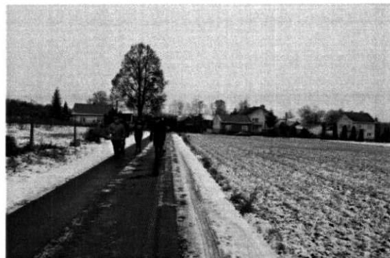
Przebudowa drogi wewnętrznej nr ewid. dz. 644 w miejscowości Kotuszów, od km 0+000 do km 0+535.
