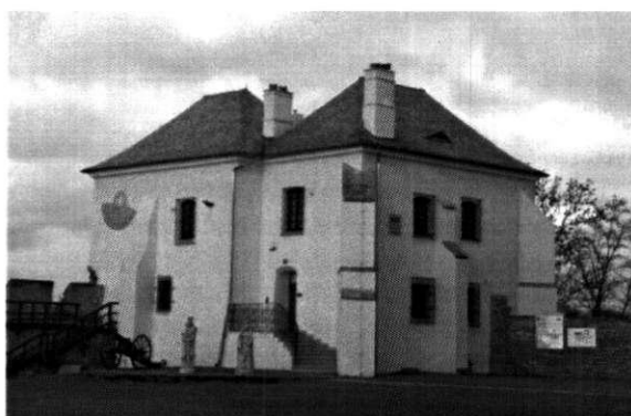
Szydłów, zespół Zamku Królewskiego, budynek „Skarbczyka” (XVI w.): prace remontowe dachu.
