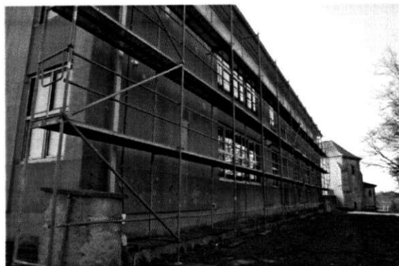
Termomodernizacja budynku użyteczności publicznej – Szkoły Podstawowej przy ul. Szkolnej 12.
